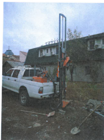
Foto.1: Aspectul terenului de fundare studiat și instalația de foraj geotehnic Pride Mount 20 utilizat.
